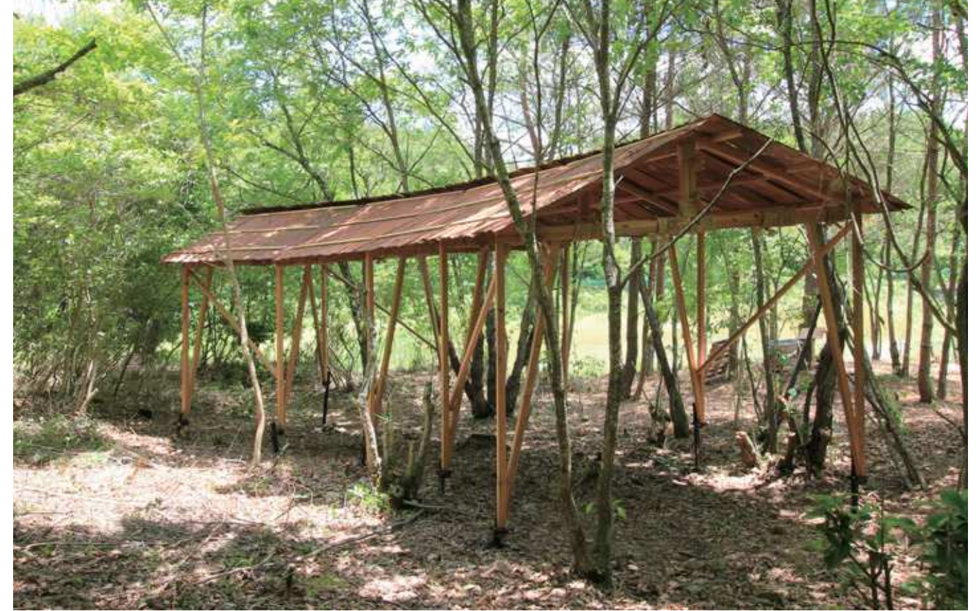
「第40回全国育樹祭」終了後、京都府南丹市園部町大河内の山林に移設された。同地区は森林の除間伐を進め、自然と共生できる環境づくりに取り組んでおり、森の魅力を感じられるスペースづくりに役立っているという
